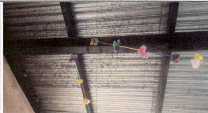
Foto 2: Sustitución de lámina, por lámina troquelada aluzinc calibre 26, módulo 2.
