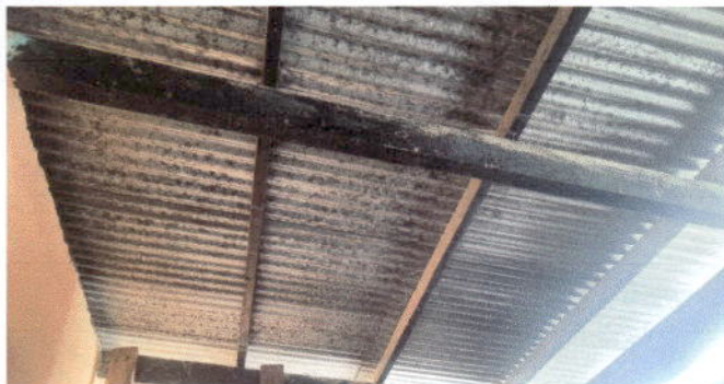
Foto 1: Sustitución de lámina, por lámina troquelada aluzinc calibre 26, módulo 1.
