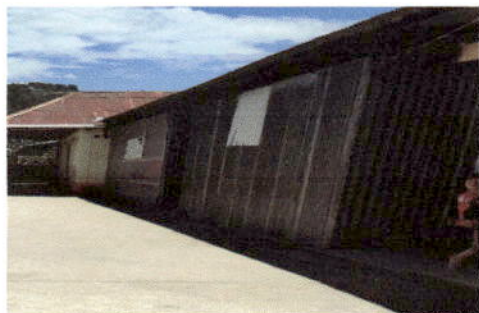
Foto 5: Sustitución de lámina, por lámina troquelada aluzinc calibre 26, módulo 1.
